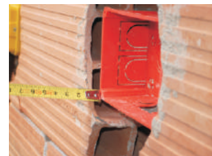
La base va posizionata all'interno della traccia da 0,5 cm fino a 2 cm di profondità
